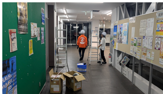
図 8: ファイバー敷設工事の写真
